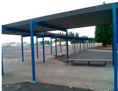
W Falling Hazard
