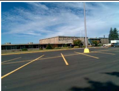
SE Elevation View
