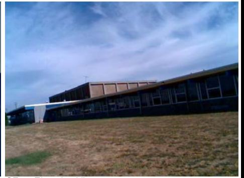
SE Elevation View
